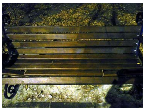
Рис. 4. Разрушенные деревянные детали в существующих объектах
