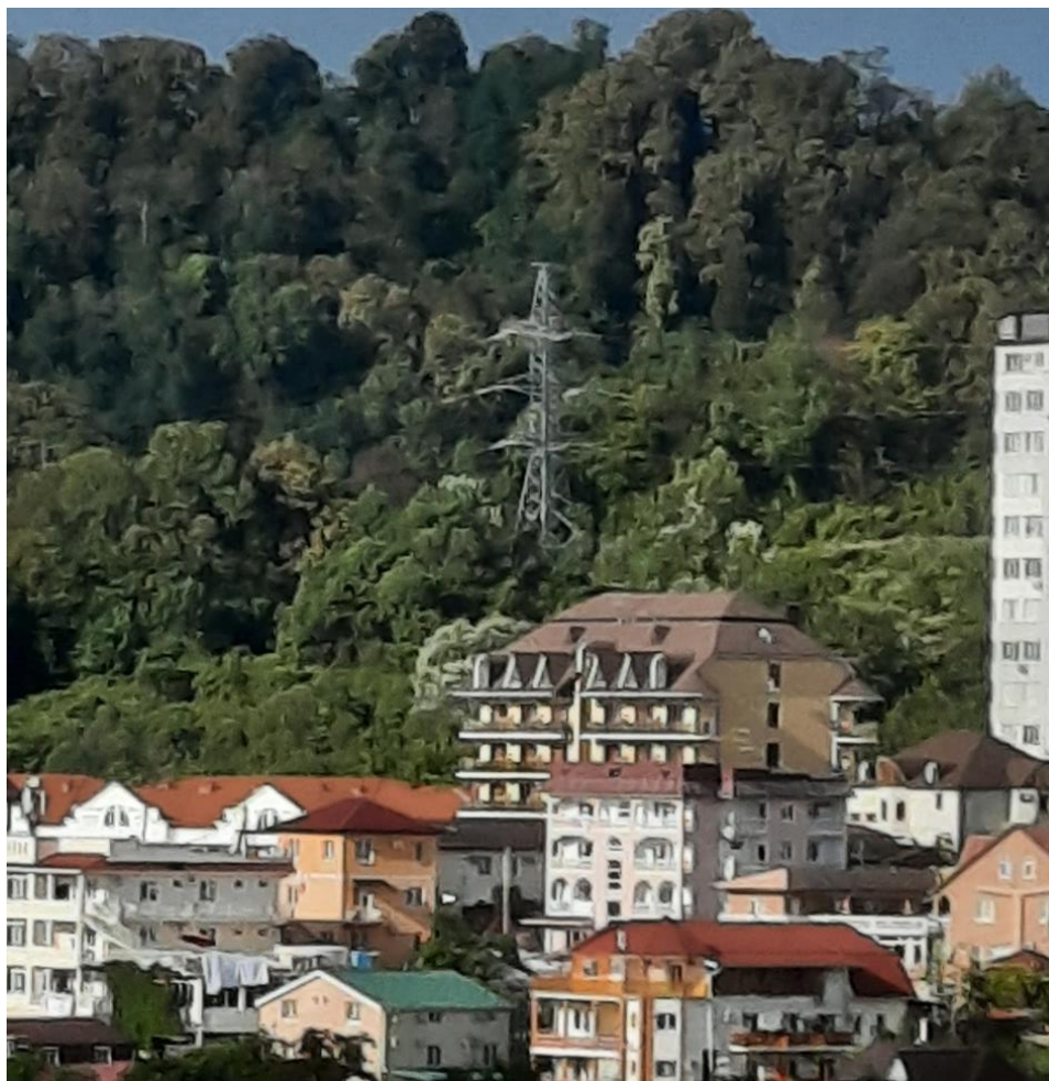
Рис. 1.12. Внешний вид воздушной линии электропередачи, расположенной в горно-лесистой местности
