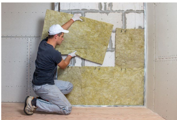
Рис. 6. Монтаж минераловатной плиты
