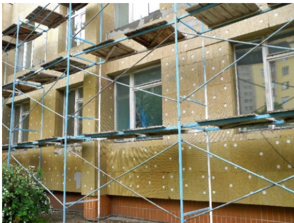
Рис. 4. Применение минеральной ваты в качестве теплоизоляции стен
