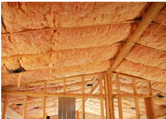
Рис. 5. Применение минеральной ваты для теплоизоляции кровли
