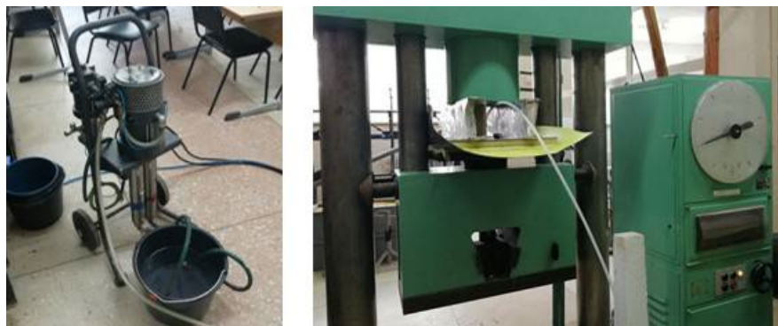
Рис. 2.11. Насос для закачки ремонтного состава (слева) и процесс закачки ремонтного состава (справа) в карты под давлением прессы
