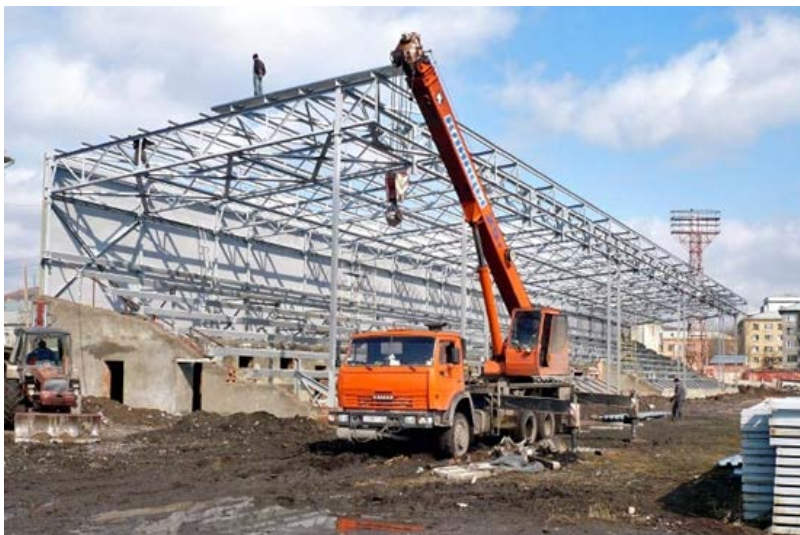
Рис. 1. Строительство трибуны стадиона
