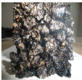
Рис. 2. Структура слоя материала после укладки в выбоину покрытия
