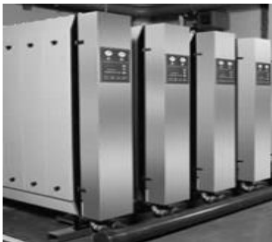
Рис. 91. Системы регенеративной фильтрации фирмы Domnick Hunter: a – передвижной модуль для ангаров и подобных сооружений; б – набор модулей для убежищ
