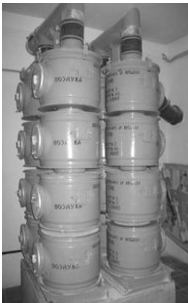
Рис. 97. Установка РУ-150/6: a – общий вид; б – патрон РП-2
