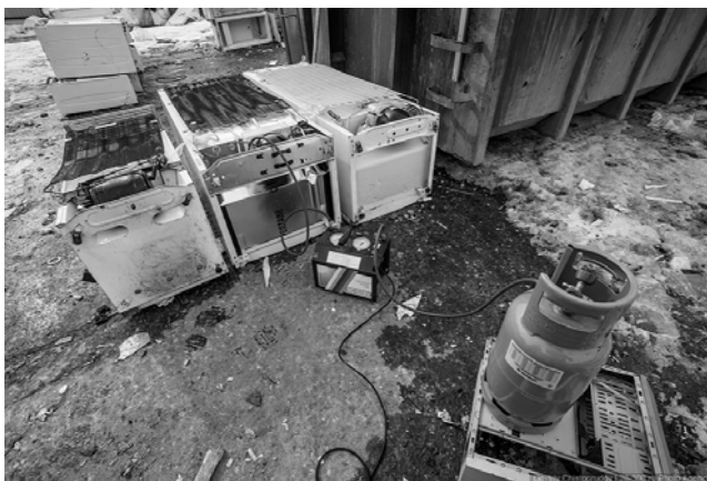
Рис. 3.4. Фото откачки фреона
