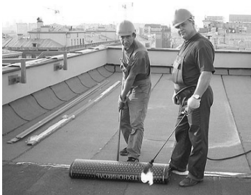
Рис. 4.2. Устройство наплавляемой битумно-полимерной кровли
