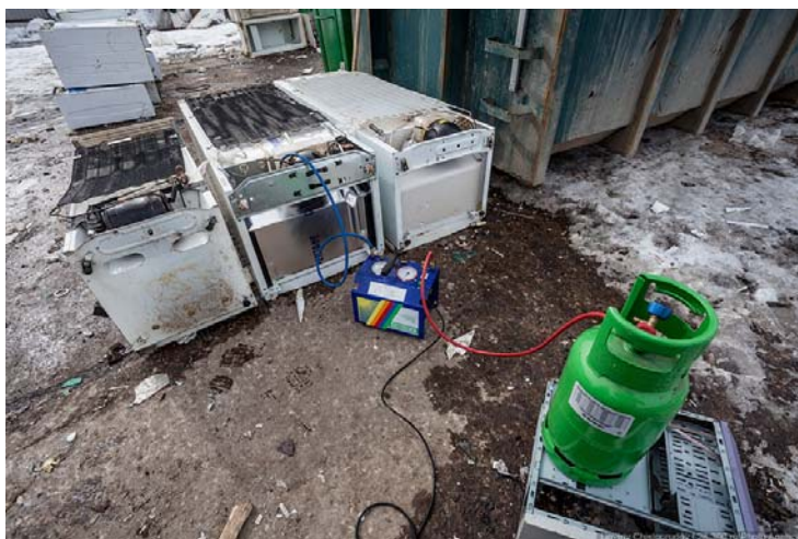
Рис. 3.4. Фото откачки фреона
