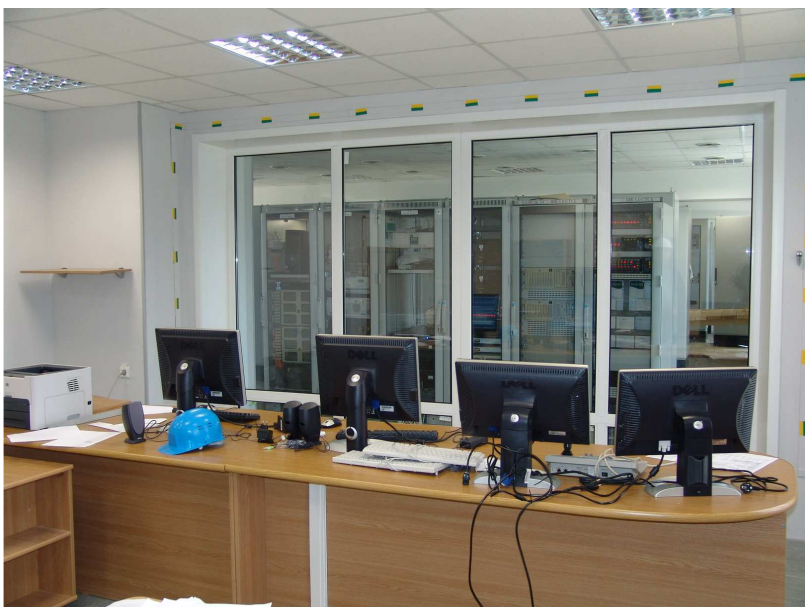
Рис. 1.21. Автоматизированная система управления технологическими процессами подстанции
