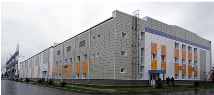
Рис. 4.5. Подстанция 500 кВ, Бескудниково
