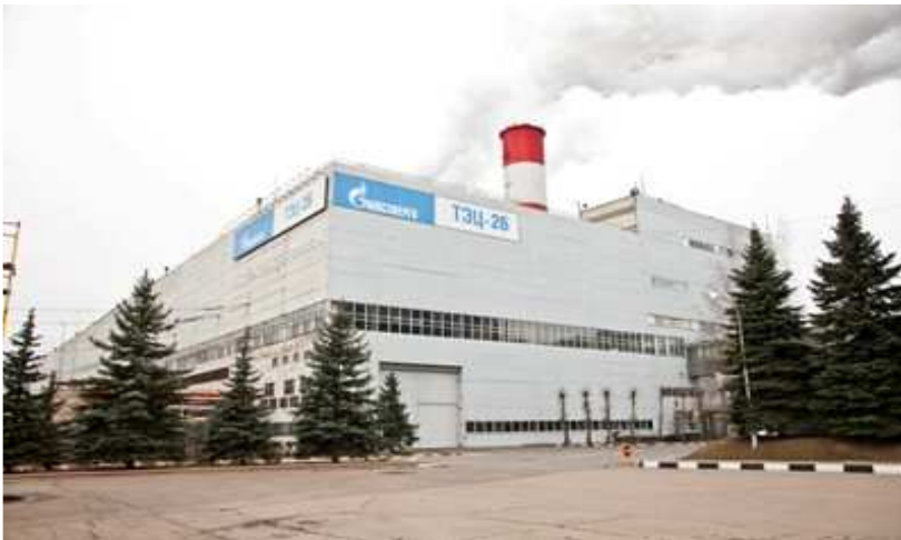
Рис. 4.10. Теплоэлектроцентраль № 26, г. Москва
