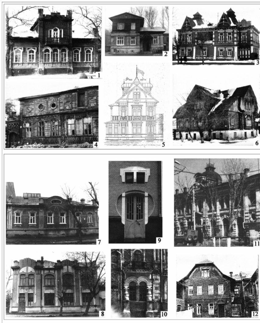
Рис. 2.11 Традиционные строительные материалы и их новое применение: дерево: 1 – 6 – усложнение завершений объемов, конструкций скатных крыш, разработка новых орнаментов фасадов, заполнений проемов; кирпич: 7, 8 – создание различных сочетаний цвета и фактур с использованием поливной керамики, декоративной штукатурки; 9 – 12 – усложнение детализировки поверхностей стен и завершений объемов
